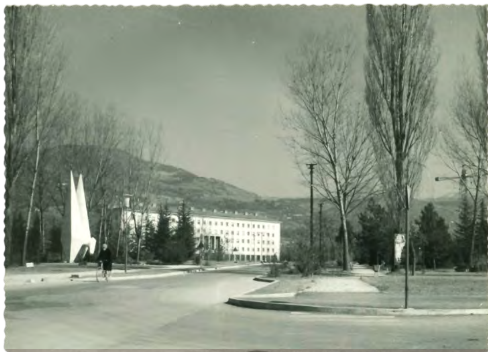
Nova Gorica, pogled s križišča Delpinove in Erjavčeve proti občinski stavbi, na levi spomenik Edvardu Rusjanu, postavljen septembra 1960, s. d. (SI_PANG/0583 Zbirka fotografij, p. e. 9/85).
