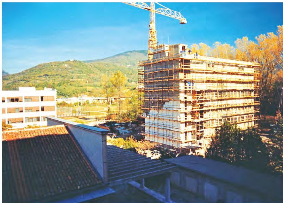
Gradnja nove arhivske stavbe, 1986 (SI_PANG/0337 Pokrajinski arhiv v Novi Gorici).
