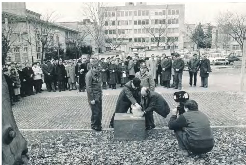
Predsednik Republiškega komiteja za kulturo Slovenije Vladimir Kavčič in ravnatelj arhiva Matjaž Grobler postavljata temeljni kamen za gradnjo nove stavbe arhiva 7. februarja 1986 (SI_PANG/0337 Pokrajinski arhiv v Novi Gorici).
